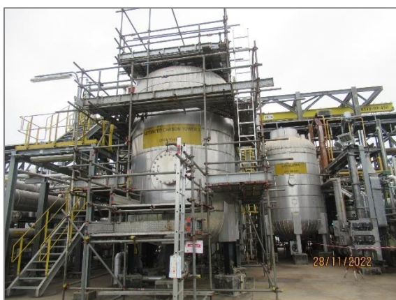
ภาพถ่ายที่ 2.2.2-9 หอถ่านกัมมันต์สำหรับดูดซับซัลเฟอร์
