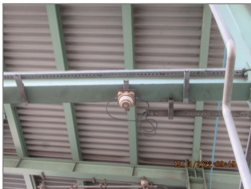
ภาพถ่ายที่ 2.2.2-67 เครื่องตรวจจับก๊าซไวไฟ (Flammable Gas Detector)
