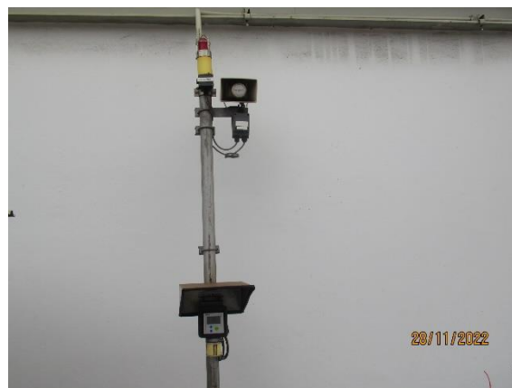
ภาพถ่ายที่ 2.2.2-58 เครื่องตรวจจับ CO แบบต่อเนื่อง (CO Concentration Online) ในส่วนผลิต CO
