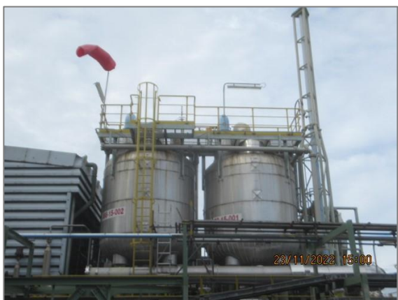
ภาพถ่ายที่ 2.2.2-2 ระบบกำจัดก๊าซเสีย (Offgas Cleaning System)
