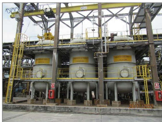
ภาพถ่ายที่ 2.2.2-8 หอเหล็กไฮดรอกไซด์ สำหรับกำจัดซัลเฟอร์
