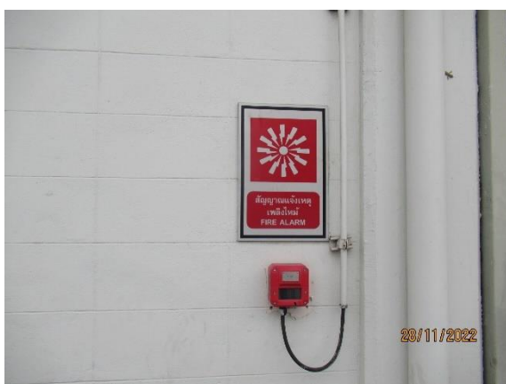
ภาพถ่ายที่ 2.2.2-59 ปุ่มแจ้งสัญญาณไฟไหม้ (Fire Alarm Button) ในส่วนผลิต CO
