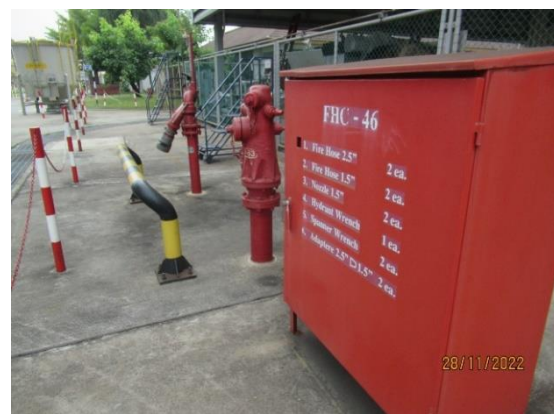
ภาพถ่ายที่ 2.2.2-56 อุปกรณ์ป้องกันและระงับอัคคีภัยในพื้นที่ส่วนผลิต CO
