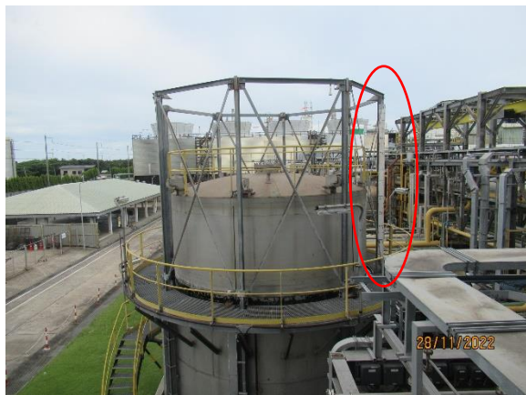
ภาพถ่ายที่ 2.2.2-45 อุปกรณ์วัดระดับแบบวัดเฉพาะ จุดแบบ Local Scale
