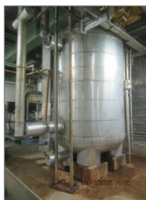
ภาพถ่ายที่ 2.2.2-60 ถังพัก (Buffer Vessel)
