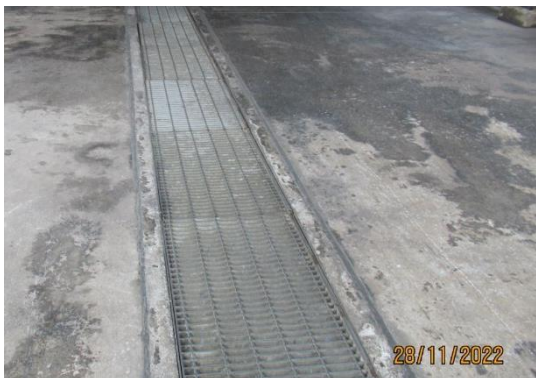
ภาพถ่ายที่ 2.2.2-23 รางระบายน้ำฝนภายในพื้นที่โครงการ
